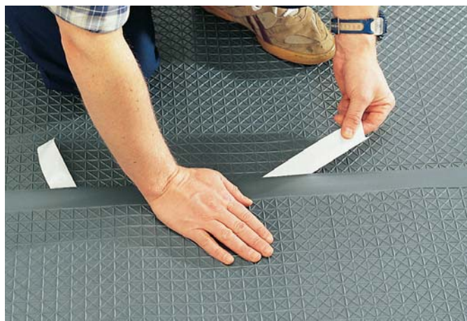
11. Ta bort skyddspappret. Börja mitt i skarven och arbeta ut mot dess ändar. Tryck samtidigt fast skarven för att få ordentligt tätt.
