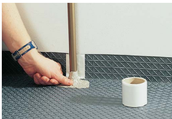
13. Vid genomföringar, skär upp och passa in Fonda Special runt genomföringen. Täta med det 50 mm breda skarvbandet så att fuktspärren blir intakt.
