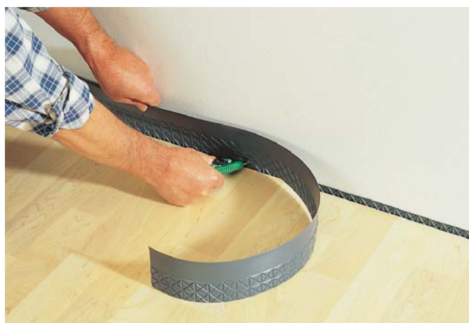
15. I de fall man har uppvik mot vägg skärs överskottet bort när golvet är färdiglagt. Renskar Fonda Special ca 10 mm ovanför färdigt golv. För väggar med uppvik används en sockellist.
