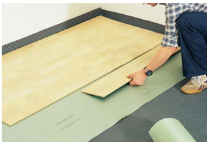
14. När Fonda Special har lagts färdigt monteras, beroende på övergolvskonstruktionen, stegljudsdämpare och/eller mellanskikt innan ytskiktet appliceras. Stegljudsdämparen hjälper även till att ta upp mindre ojämnheter i underlaget. För att minimera höjdskillnader vid skarvar i Fonda Special, kan stegljudsdämparen skäras bort vid dessa skarvar.
