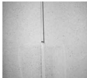
Skapa ett mellanrum på 5-7 mm vid FERMACELL-fogspackelskarven.
