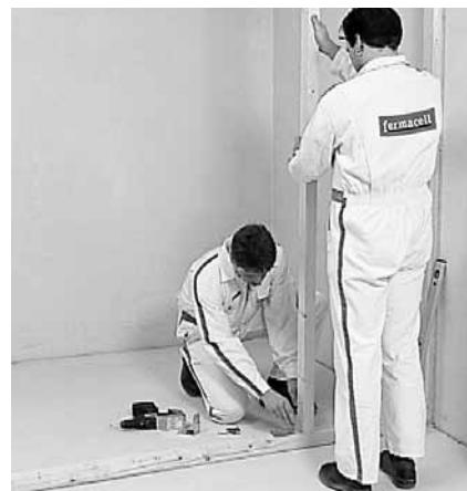
Ovan: System med åtskild/ dubbel underkonstruktion.
