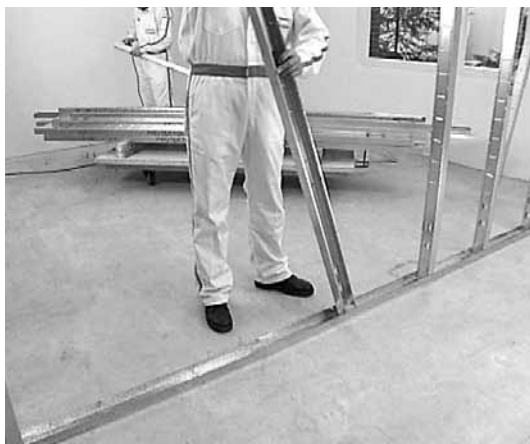
Montering av stålprofiler i topp- och bottenskena av stål.
