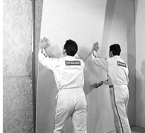
Montering av skivor på underkonstruktion av trä.
