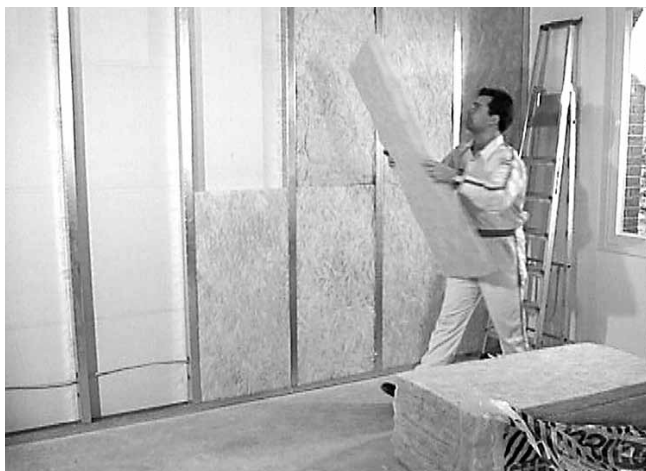
Montering av mineralull
