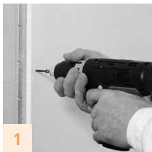
1 Skruva fast – eller montera med klammerpistol
