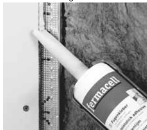
Limfog appliceras i mitten av skivkanten i en limsträng på 3 mm.
