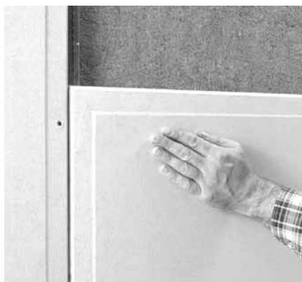
Skarvning av fibergipsskivor med spackelkant.
