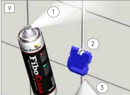
9 OBS! Det ska tränga ut fogmassa längs hela skivan när skivorna klickas samman. Spraya Fibo Clean på överflödigt fogmassa. Ta bort med Fibo fogkloss. Torka bort eventuell kvarvarande fogmassa med Fibo Wipes.
