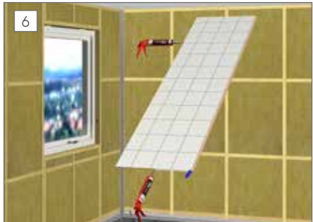
6 Påför godkänd fogmassa på sågade ytor. Se bild. Dra ut fogmassan med fogkloss.
