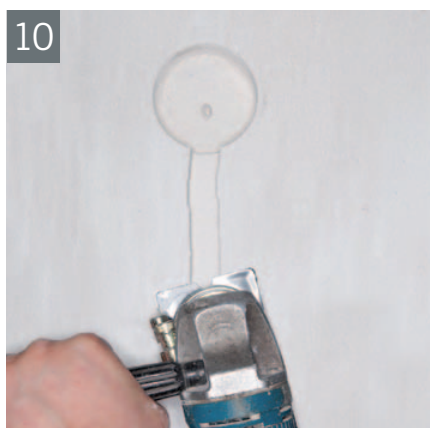
Använd dosbörst eller dosfräs för att göra hålet till eldosan/kopplingsdosan. Fräs sedan spåret till elröret med en spårfräs. Vid tunna multiplattor bör man alltid fräsa spåret i höjdlid och inte i sidled.
