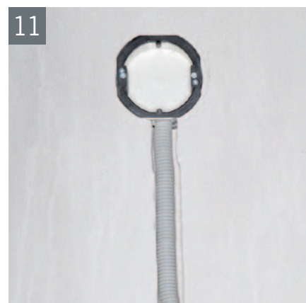
Montera eldosan och elröret med tillhörande sladdar.
